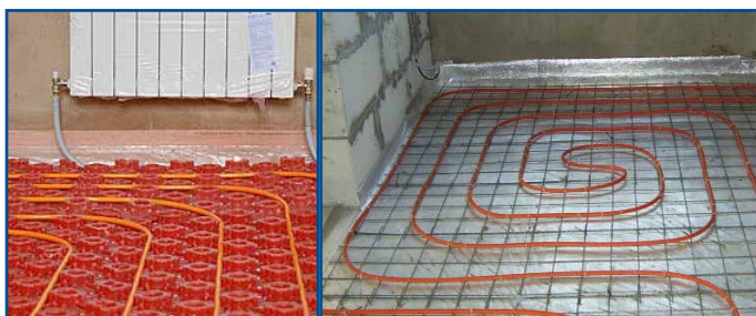
Примеры укладки трубы SANEXT «Теплый пол»
