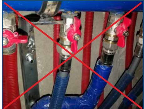
Ошибка: подключение фитинга типа евроконус к шаровому крану с плоской присоединительной площадкой
