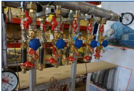
Гидравлические испытания РКУ SANEXT
